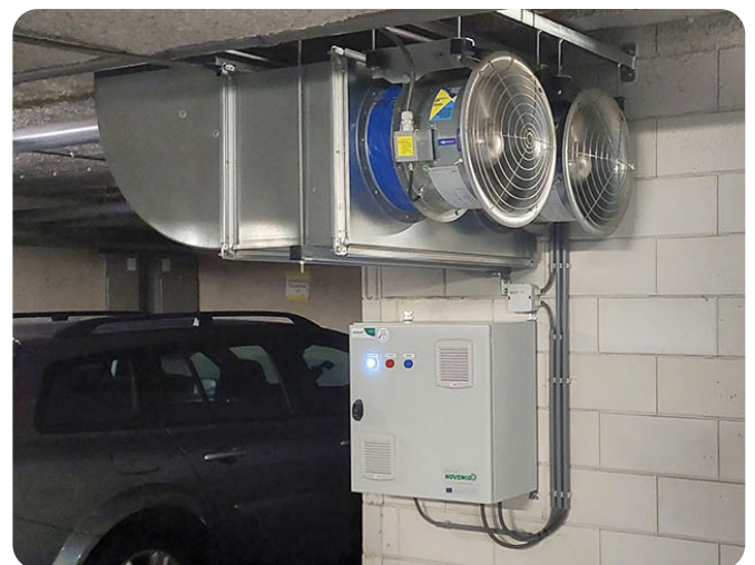
Das neue Belüftungssystem mit platzsparenden ZerAx-Ventilatoren
