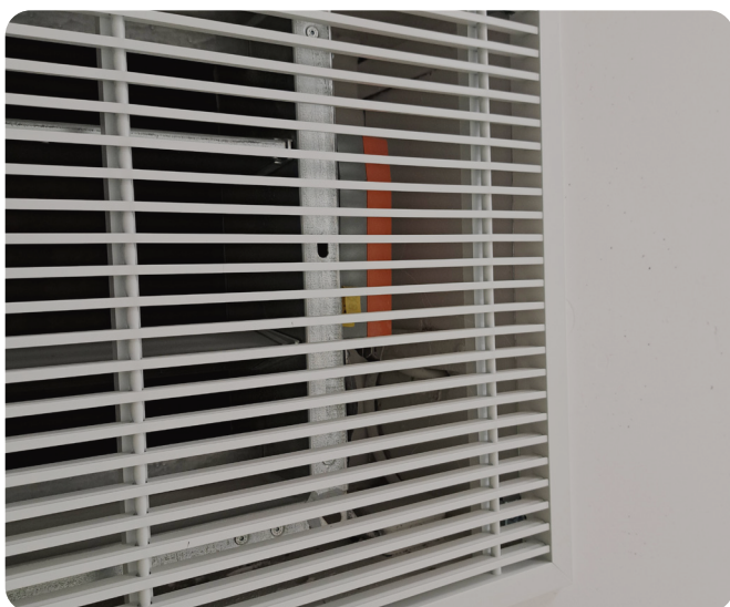
Im Korridor montierte Kombinationsklappe und Auslasslamelle, die als Teil des Systems einen präzisen Luftstrom und einen homogenen Druck gewährleistet.
