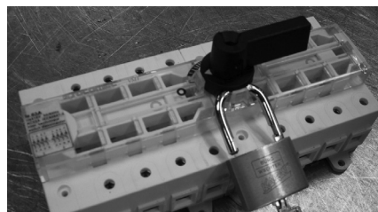
Figur 6. Afbryder låst i Off position
