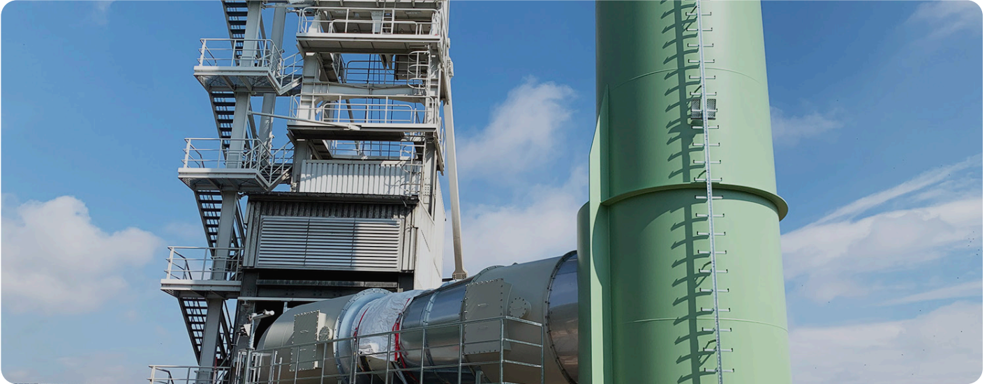
GTS Grube Teutschenthal Sicherung, Deutschland
