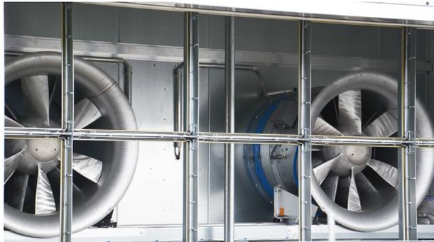
NOVENCO Axialventilatoren im Parallelbetrieb
