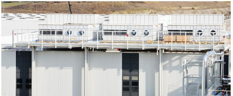
Zentral über dem Firmengelände thronen die RLT-Geräte der neuesten Generation. Die Zuluftventilatoren sind direkt am Ende des Gerätes platziert.
