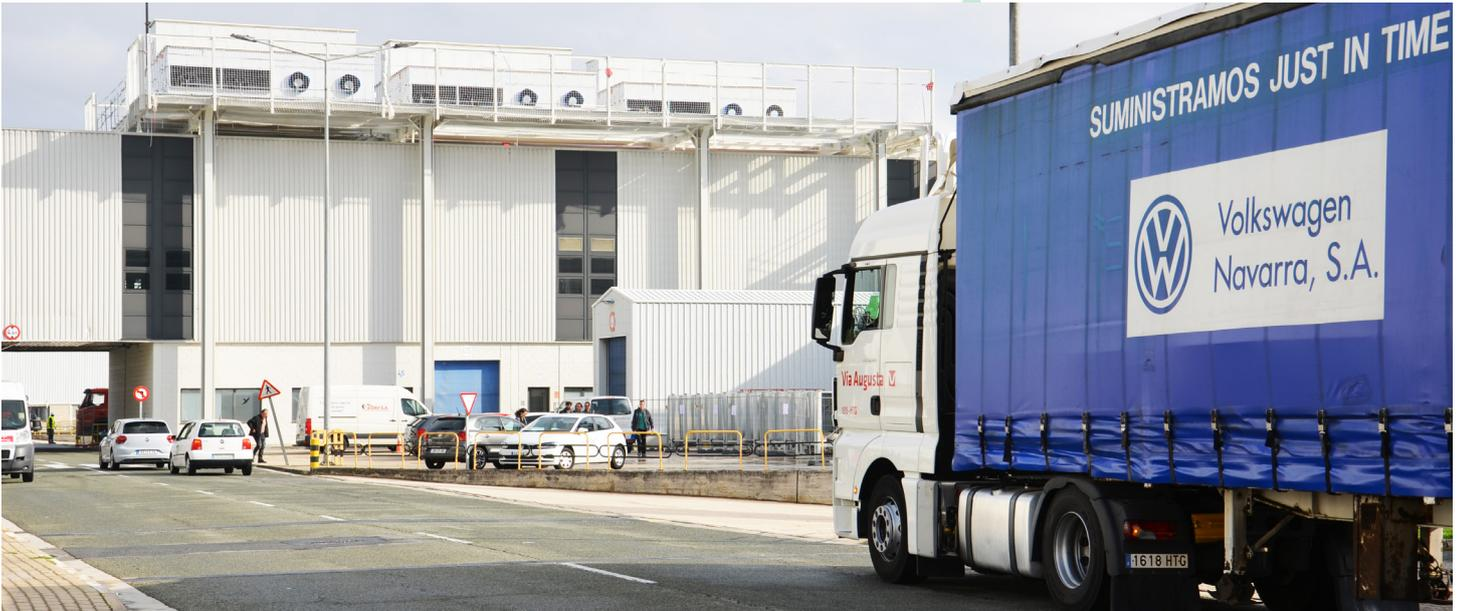
3 RLT-Dachgeräte mit je 80.000 m<sup>3</sup>/h auf einer Stahlkonstruktion
